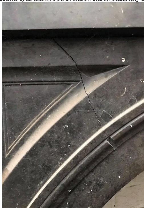
Fot. 15. Kominek z czarnego marmuru w pomieszczeniu nr 2.1, fragment. Widoczne pęknięcie ukośne oraz ubytek profilowania. Budynek „Kossakówka, Pl. Kossaka 4, Kraków. Fot. D. Narowska Avonza, luty 2021
