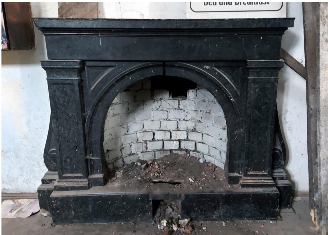
Fot. 14. Kominek z czarnego marmuru w pomieszczeniu nr 2.1. Stan dość dobry, widoczne zabrudzenie, zmatowienie oraz niewielkie lecz liczne ubytki górnej krawędzi belkowania oraz krawędzi lizen. Budynek „Kossakówka, Pl. Kossaka 4, Kraków. Fot. D. Narowska Avonza, luty 2021
