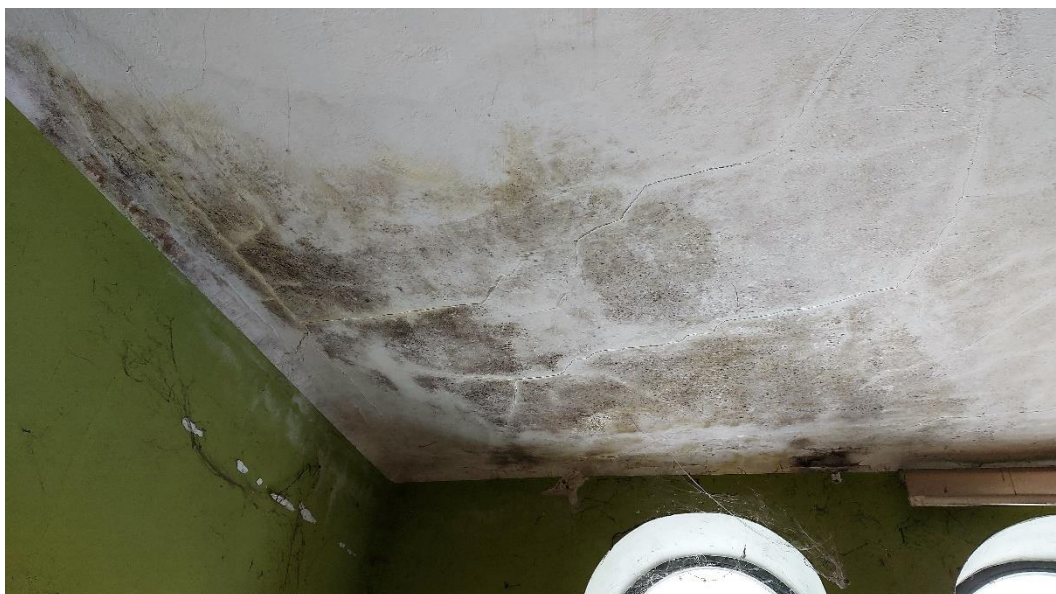
Fot. 10.. Widok tynków wewnętrznych w pomieszczeniu 2.2. Bardzo zły stan, widoczny bardzo zaawansowany rozwój mikroorganizmów, rozległe spękania i łuszcząca się z powodu wilgoci i wysoleń farba. Budynek „Kossakówka, Pl. Kossaka 4, Kraków. Fot. D. Narowska Avonza, luty 2021 r.
