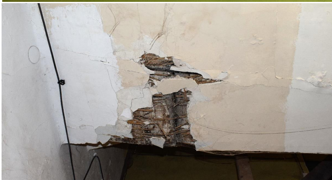
Fot. 11, 12, 13. Widok tynków wewnętrznych w pomieszczeniach kolejno od góry: W0.2, 2.2 i W0.4. Bardzo zły stan, widoczne spękania, bardzo zaawansowany rozwój mikroorganizmów, złuszczenia, duże odspojenia. Na fotografii 13 widoczny rozległy ubytek tynku odsłaniający budowę stropu. Budynek „Kossakówka, Pl. Kossaka 4, Kraków. Fot. D. Narowska Avonza, luty 2021 r.
