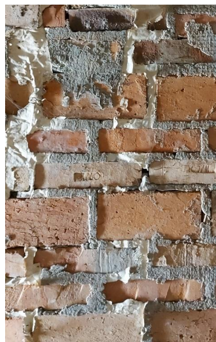
Fot.3, 4 .Fragment stropu Kleina w pomieszczeniu piwnicznym. Po prawej stronie widoczne pozostałości tkaniny i wyprawy tynkarskiej, a także znaki cegielni. Budynek „Kossakówka, Pl. Kossaka 4, Kraków . Fot. D. Narowska Avonza, styczeń 2022 r.
