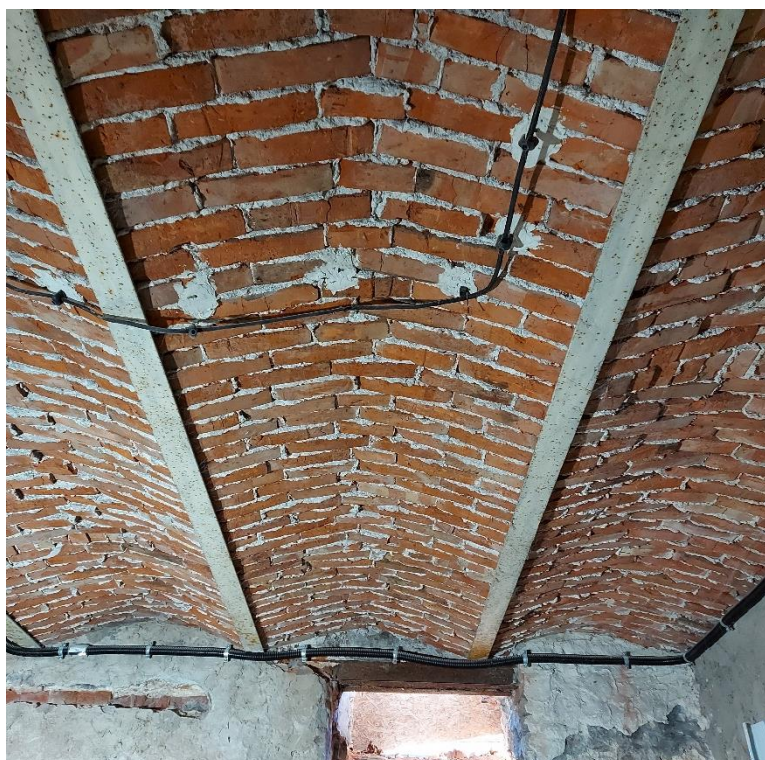
Fot.1,2 .Fragment stropu odcinkowego w pomieszczeniu piwnicznym. Po prawej stronie widoczny zły stan zachowania belek stalowych, powstające produkty korozji powodują odpajanie się powłoki malarskiej. Budynek „Kossakówka, Pl. Kossaka 4, Kraków . Fot. D. Narowska Avonza, styczeń 2022 r.
