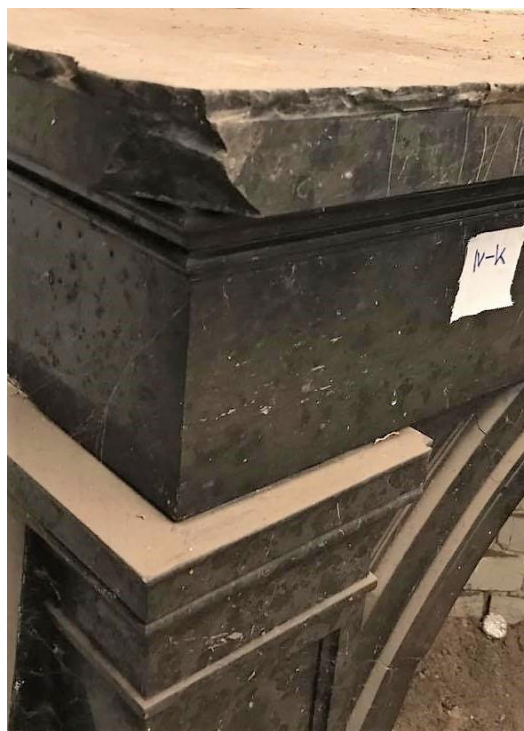
Fot. 16. Kominek z czarnego marmuru w pomieszczeniu nr 2.1, fragment. Widoczne ubytki formy narożnika i górnej krawędzi. Budynek „Kossakówka, Pl. Kossaka 4, Kraków. Fot. D. Narowska Avonza, luty 2021
